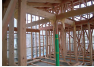
躯体構造(柱・梁桁)
