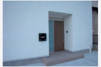
外装(玄関ポーチ+サイディング張り)
