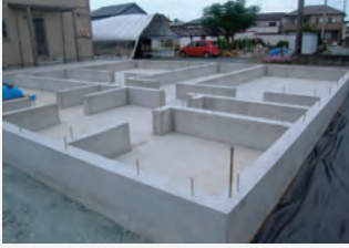
躯体構造(基礎)
