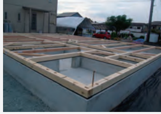
躯体構造(土台・大引)
