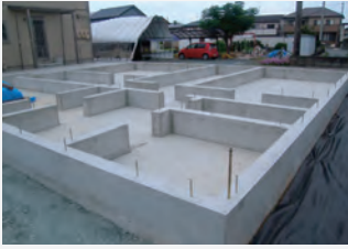
躯体構造(基礎)
