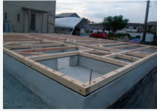
躯体構造(土台・大引)
