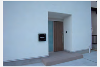
外装(玄関ポーチ+サイディング張り)
