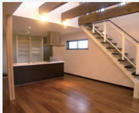
内装(複合板フローリング+壁・天井クロス)
