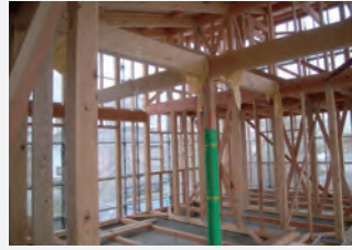
躯体構造(柱・梁桁)
