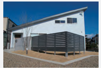
外装(ガルバリウム鋼板屋根+ガルバリウム鋼板張り)
